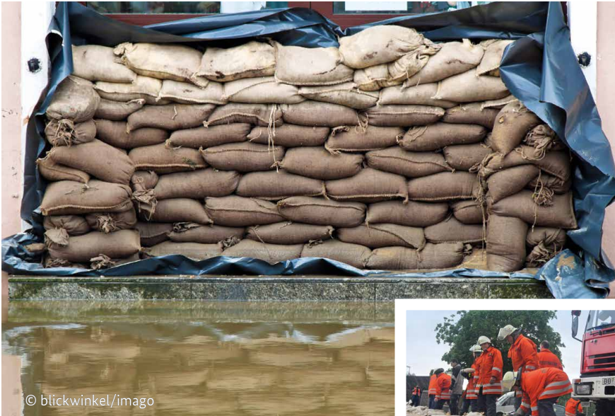
Schutzwälle aus Sandsäcken
